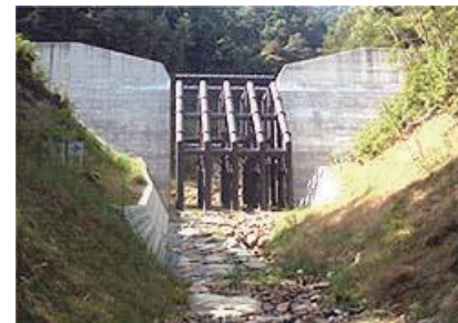
透過型砂防えん堤の例（広島県） 6)
