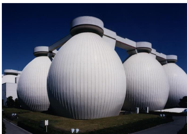
図 2-68 卵形消化タンク (北部汚泥化資源センター)
