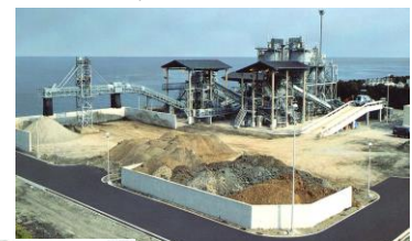
改良土プラント
