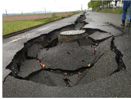
地震による下水道管上部の道路陥没 (熊本地震)
