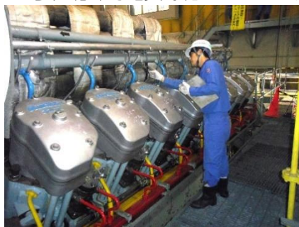
図 2-2 水再生センター施設・設備の点検
