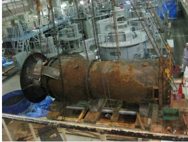
ポンプ再整備前
