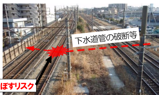
図 2-11 鉄道（軌道下の下水道管の耐震化を推進）
