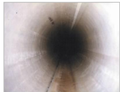
管更生工法による施工
