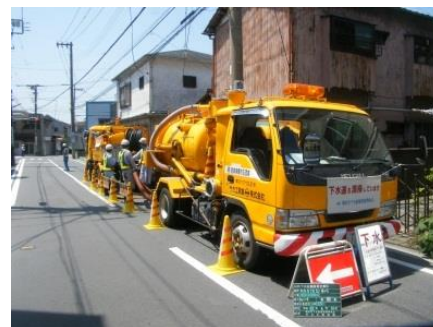
図 2-3 吸引車による下水道管の清掃
