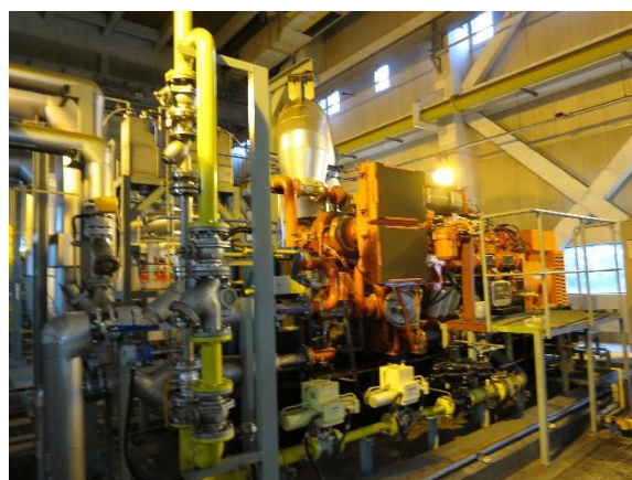
図 2-69 消化ガス発電
