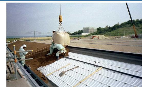
写真 湿性多孔質軽量人工土壌の施工
