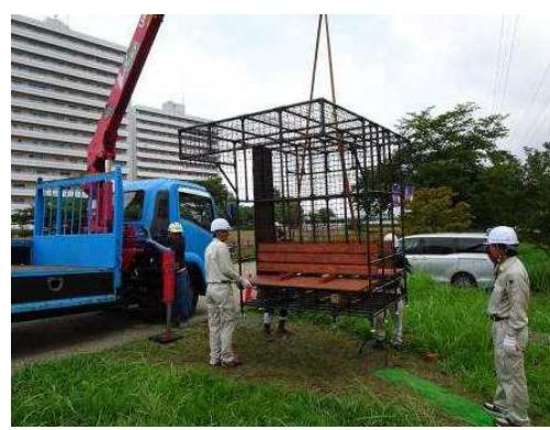
写真 組み立てた状態での搬入の様子
