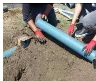
写真 通気透水管の敷設
