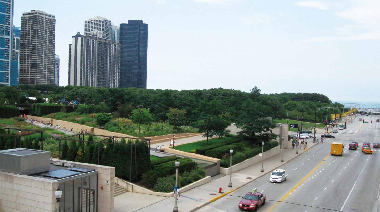
写真4-4 ミレニアムパーク、シカゴ市 世界一大きな人工地盤緑化(10ha)の下には、鉄道、駐車場、コンサートホールまで設置されている。(2010年)
